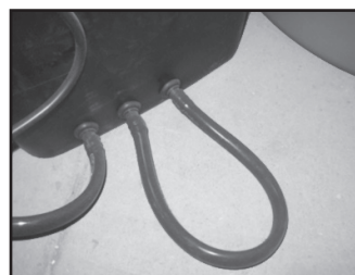
Sorties non utilisées branchées à la tuyauterie
